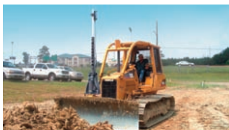
Préparation de chantier
