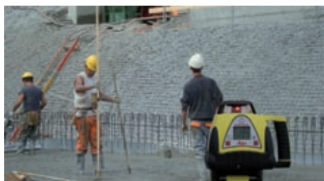
Coulée de béton
